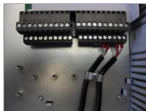
(b) Exemplo de ligação da blindagem ao terra
